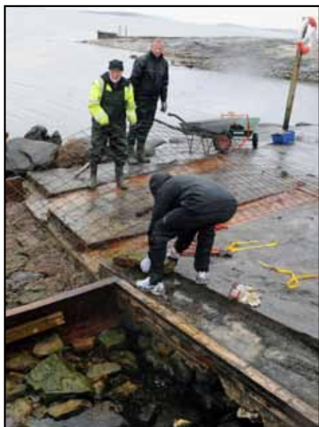
Den gamla sjösättningsrampen ersattes av en ny. Bilden tagen inför gjutningen.
